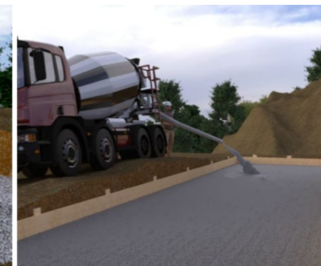
Укладка фундаментных плит или заливка бетонного основания
