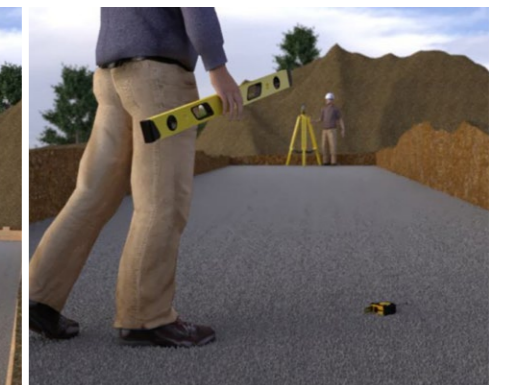
Проверка уровня высот закладных деталей
